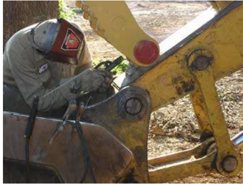
Resim 6.44: Ark kaynağı tarım makinelerinin bakım ve onarımında kullanılır
