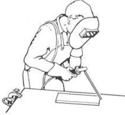
Resim 6.59: Yatay konumda kaynakçının duruşu.
