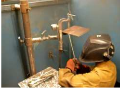
Resim 6.1: Ark kaynağında tavan pozisyonu
